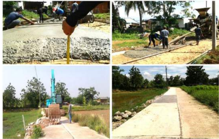
โครงการก่อสร้างปรับปรุงภูมิทัศน์คู่ออกกำลังกายรอบสระหนองใหญ่ ชุมชนหนองใหญ่หมู่ที่ ๔ ตำบลบ้านแหลม อำเภอบ้านแหลม จังหวัดนครราชสีมา
